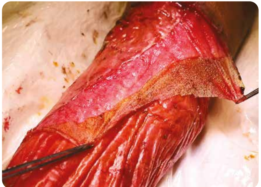
Deslaminación de la membrana de sellado.
